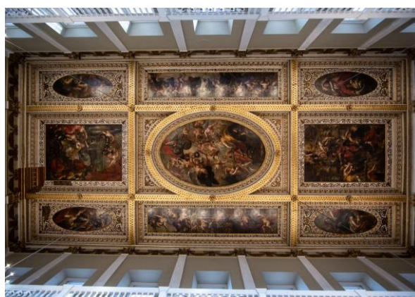
Slika 5. Rubens, frontalni pogled na strop sa slike 4.
